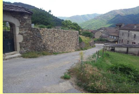
Le mur reconstruit
