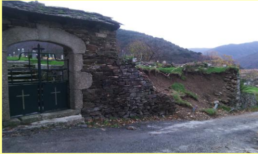
Le dégât causant une large ouverture du cimetière
